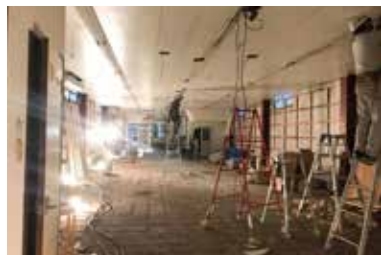
施行中の園舎の様子
